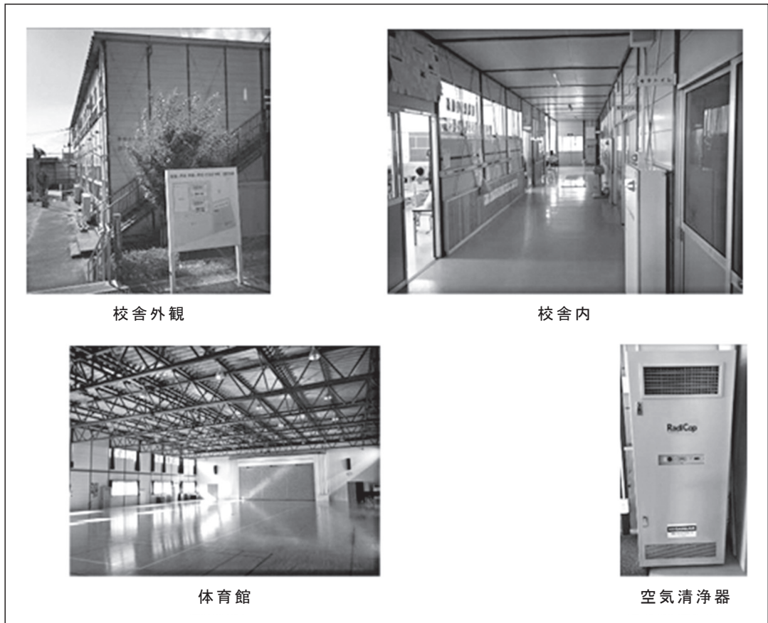
図3 飯館村村外仮設川俣校舎の様子
